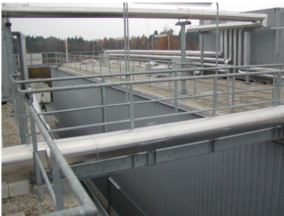
Foto 3: BPS u Passau. Jeden ze tří horizontálních fermentorů: každý z nich má délku 32 metrů a je 7 metrů vysoký.
